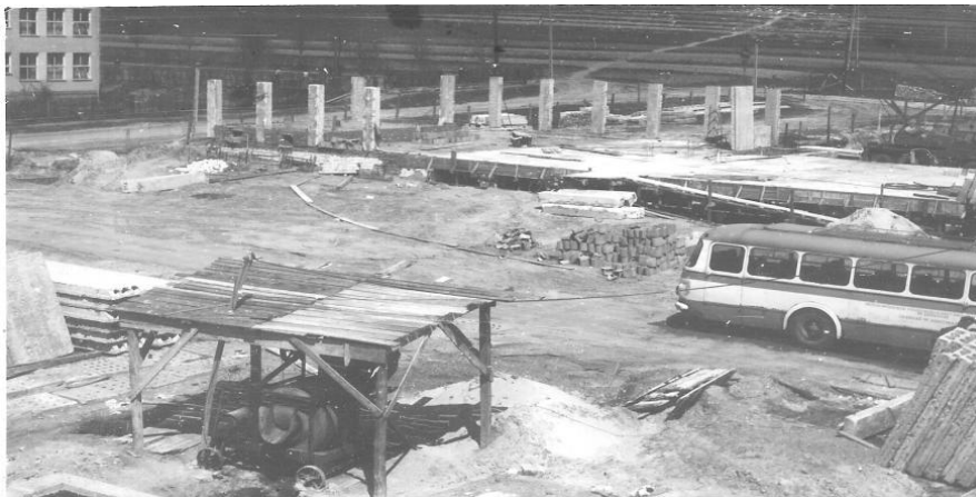
Budowa nowego budynku szkoły przy ulicy Ogrodowej. Rok 1971.
