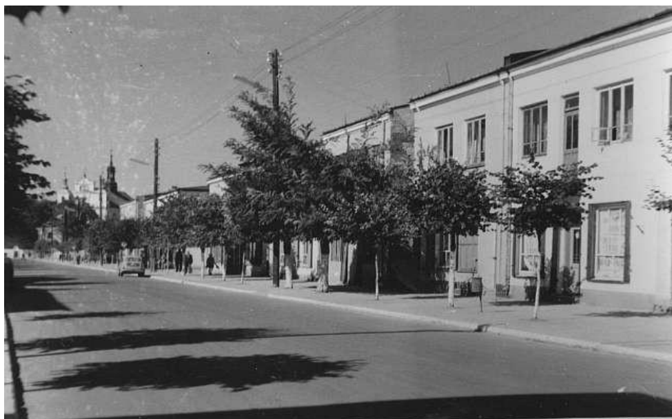
Odbudowany budynek szkoły. Widok od ulicy Zamoyskiego.
