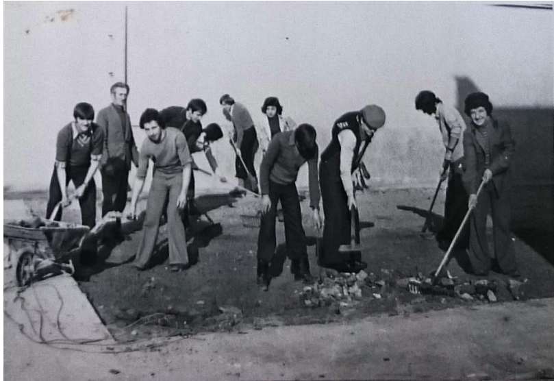
Prace porządkowe przed internatem szkolnym. Rok 1978.
