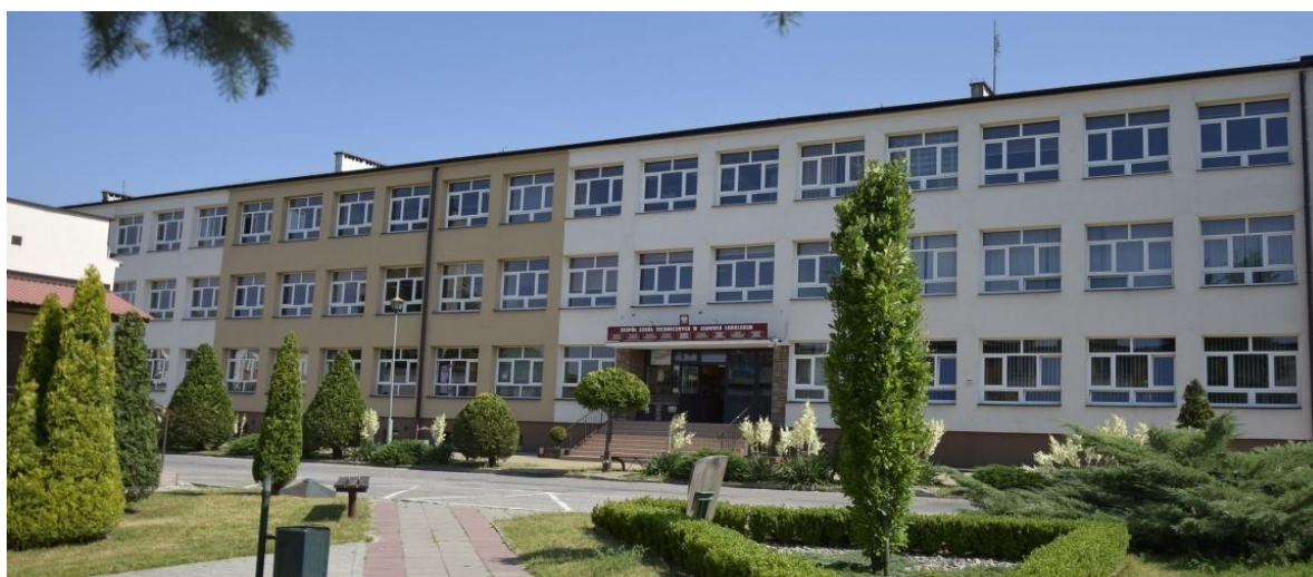
Budynek dydaktyczny Zespołu Szkół Technicznych. Rok 2016
