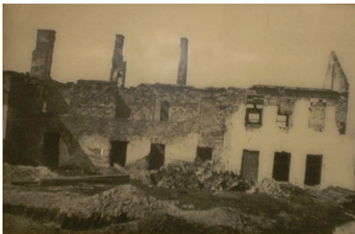
Ruiny budynku przy ul. Zamoyskiego – siedziba przyszłej szkoły. Rok 1945.
